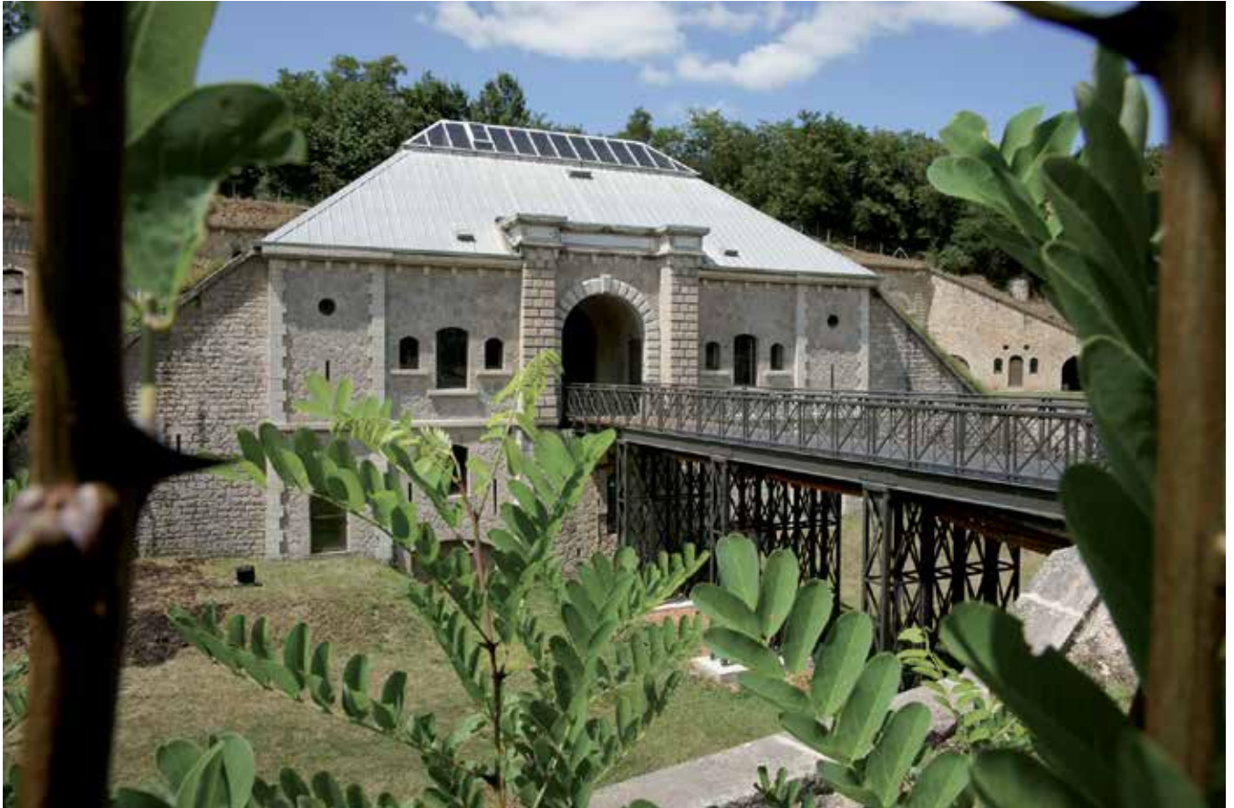
Fort de Bruissin © N. Rodet
